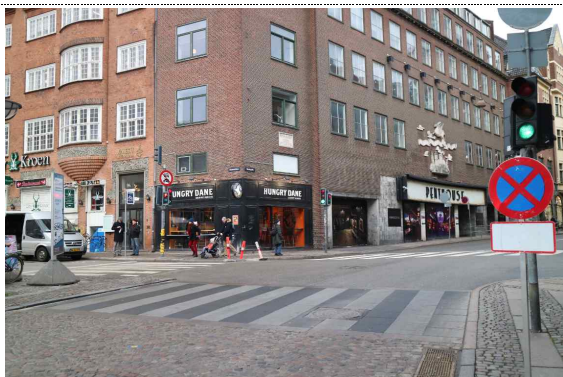
블록포장을 이용하여 횡단보도 설치 출처: 직접촬영
