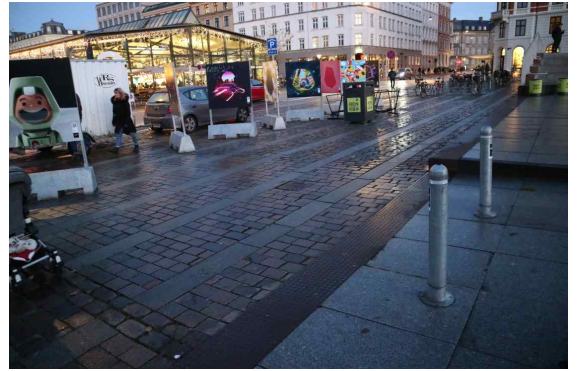
보도와의 단차를 없애고 차량 진입 제한을 위해 볼라드 설치
