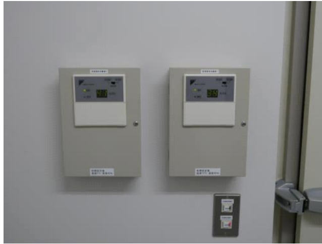
[그림 32] 교토학 역채관 수장고의 온습도 관리 시스템
