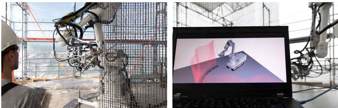
현장 제작 로봇을 통한 메쉬 몰드 제작 과정 (출처: http://dfabhouse.ch/in_situ_fabricator )
