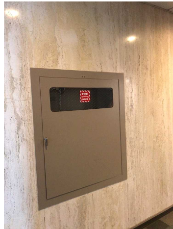
[그림 36] Prudential Tower 50층 에 설치된 옥내소화전설비
