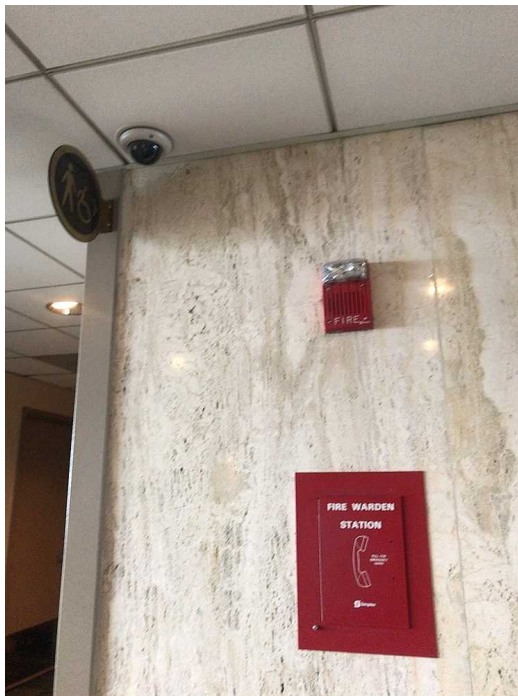
[그림 32] Prudential Tower 50층의 경보설비 및 비상방송설비
