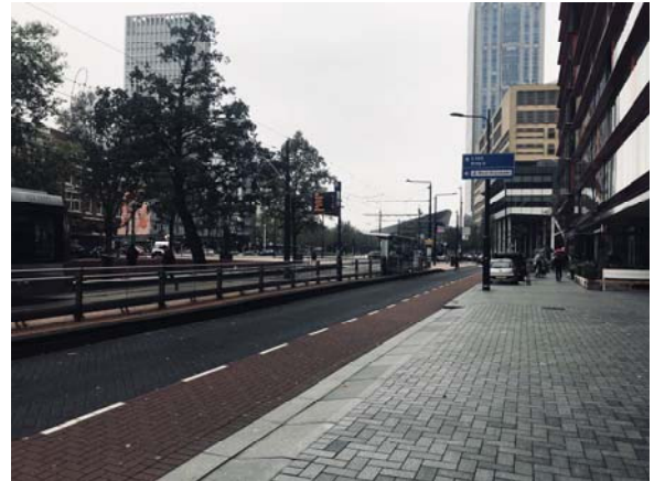
- 로테르담 가로 구성 - 중앙은 트램, 차로(폭 2.75~3.00 미터), 자전거(폭 3.00미터), 보도(2.00 미터 이상)으로 구성되어 있음
