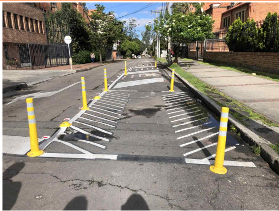
편측 내민보도 설치 모습
