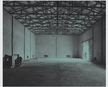
양곡창고로 쓰이던 기존의 단층 콘크리트 건물
