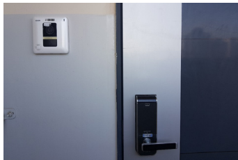
자동잠금장치 및 비디오폰이 설치된 세대 출입문
