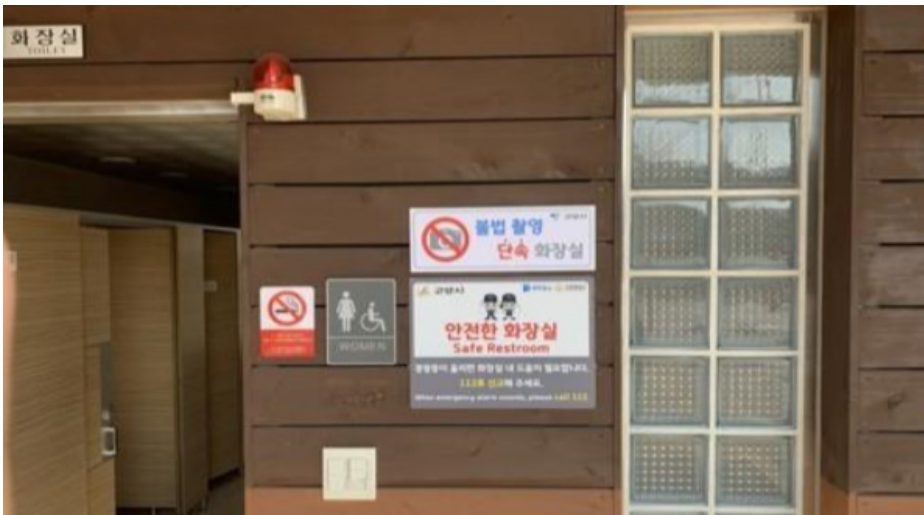
[그림 5-75] 공중화장실 유리벽돌 설치 예시
