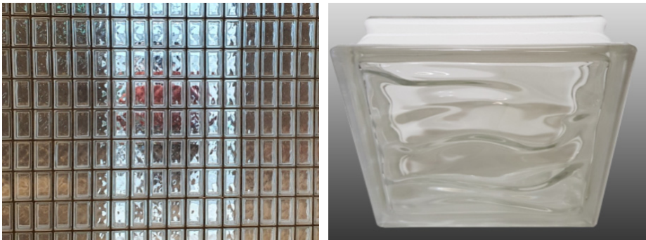
[그림 5-74] 유리벽돌 설치 예시
