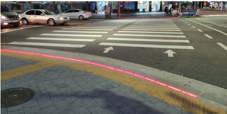
[그림 5-15] 바닥신호등 설치 사례
