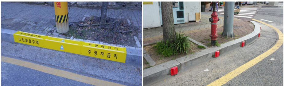
[그림 5-84] 가로경계석 표시 및 표지병 설치 사례
