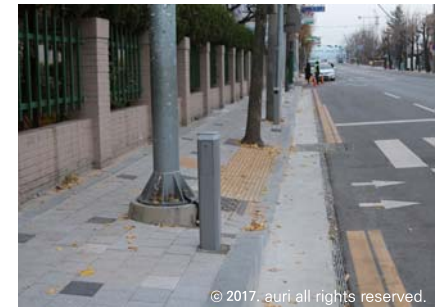
[그림2-8] 횡단보도 진출입부의 급격한 기울기의 경사로
