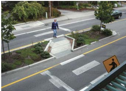
[그림2-17] 중양 보행섬 설치 유형 (Danish offset)
