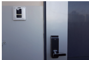
자동잠금장치 및 비디오폰이 설치된 세대 출입문
