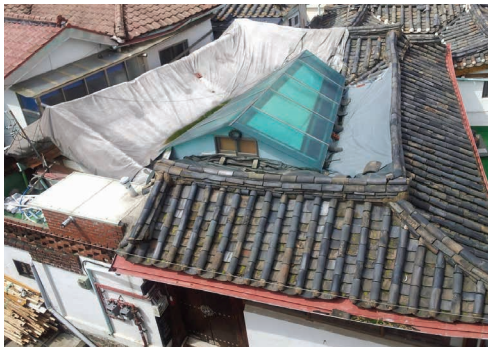
그림5. 증축으로 인한 한옥 형태의 훼손 (출처 : 한옥수선 지원 심의자료, 서울시 한옥문화과)
