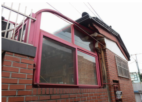
그림6. 내부공간 개조로 인한 한옥공간 특성 상실 (출처 : 한옥수선 지원 심의자료, 서울시 한옥문화과)
