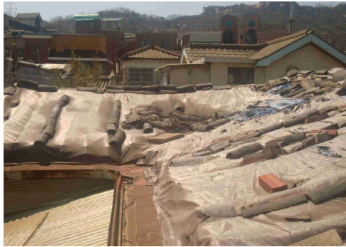
그림2. 누수의 피해를 막기 위해 임시로 설치한 천막 (출처 : 한옥수선 지원 심의자료, 서울시 한옥문화과)
