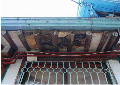
그림1. 누수로 인한 연목부식(좌), 누수로 인한 벽체 곰팡이(우)
