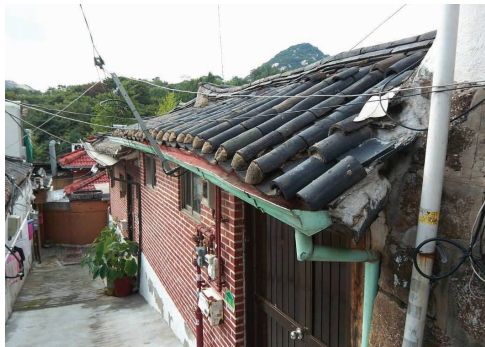
그림5. 증축으로 인한 한옥 형태의 훼손 (출처 : 한옥수선 지원 심의자료, 서울시 한옥문화과)
