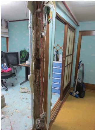
그림3. 흰개미로 인한 기둥과 바닥의 부식
