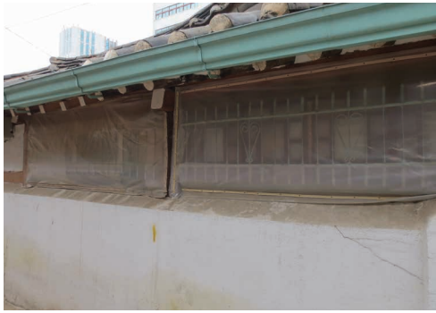
그림4. 틈새로 들어오는 바람을 막기위해 임시로 비닐막 설치(좌) 및 우레탄방수 설치(우)
