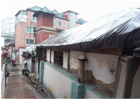
그림2. 누수의 피해를 막기 위해 임시로 설치한 천막 (출처 : 한옥수선 지원 심의자료, 서울시 한옥문화과)
