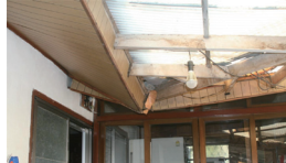
그림 5. 지붕 회첨부가 내려앉은 모습(수원)
