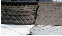
그림 5. 지붕 회첨부가 내려앉은 모습(수원)
