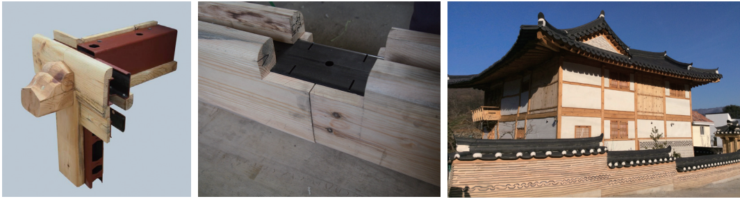
그림 4. 철골프레임 목재의 마감공법 개발사례 및 한옥건축사례
