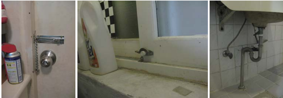
[그림 2-10] 현관문 잠금장치, 세면대 파이프교체 등을 지원 받은 A-9가구의 시공 내용
