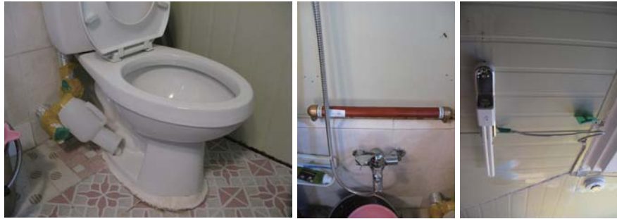
[그림 2-14] 화장실 변기, 안전손잡이, 형광등교체 등을 지원 받은 D-5가구의 시공 내용
