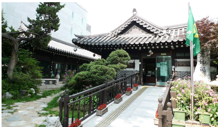
[그림 2-22] 한옥의 경사로 설치 사례 (종로구 혜화동 주민센터)
