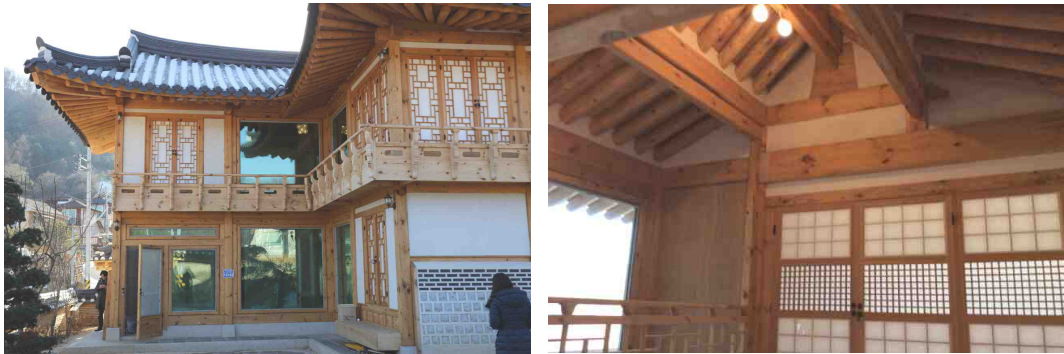
[그림 6-6] 공장에서 제작된 철골과 목재로 구조체를 형성한 한옥 실험동 사례
