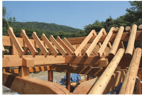
(b) 각형서까래를 이용한 단연의 시공모습
