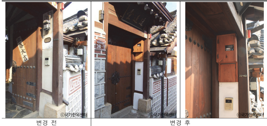
[그림 5-6] 노출되어 있는 계량기 차폐를 위한 계량기함 설치
