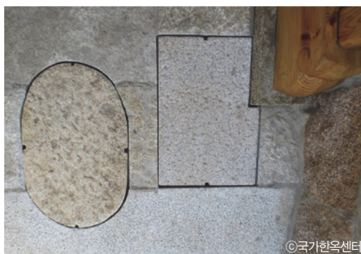
[그림 5-14] 미관을 고려한 수도계량기 및 배수구 설치 사례
