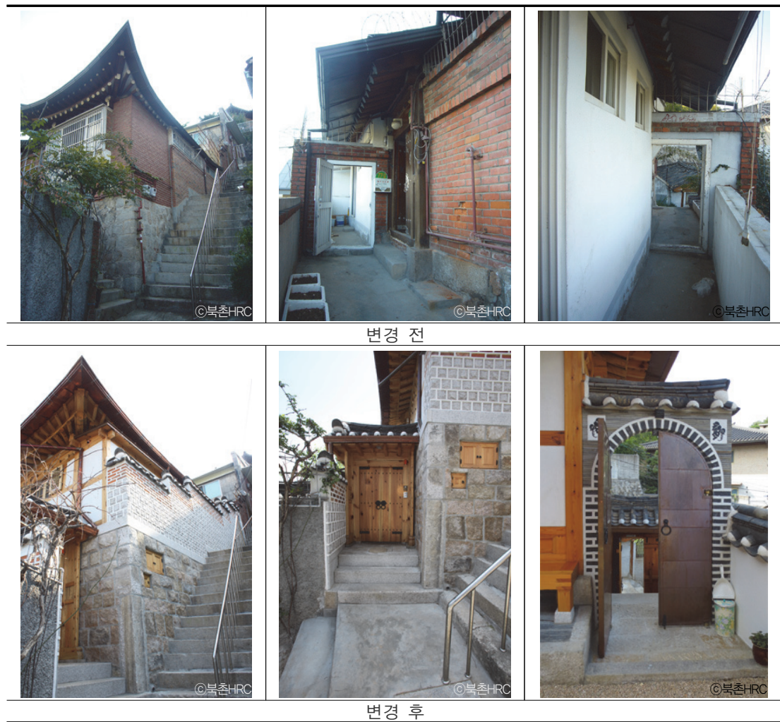
[그림 4-12] 경사지에 위치한 한옥의 이중 대문 설치 사례-변경 전·후 사진
