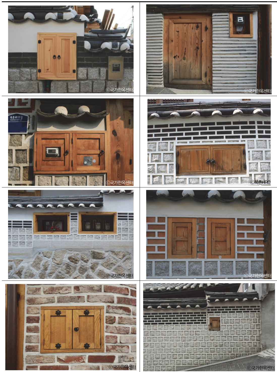
[그림 5-12] 미관을 고려한 전기 및 가스계량기 설치 사례-3
