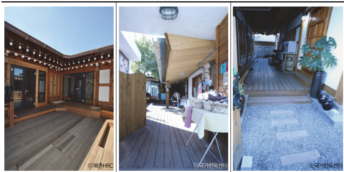
[그림 2-10] 데크를 설치하여 내부와의 단차를 줄여 공간활용
