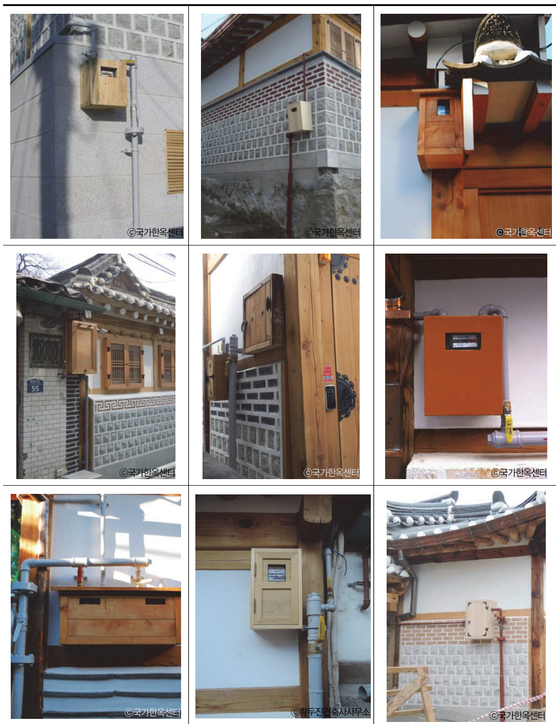
[그림 5-8] 계량기함 설치 사례-2
