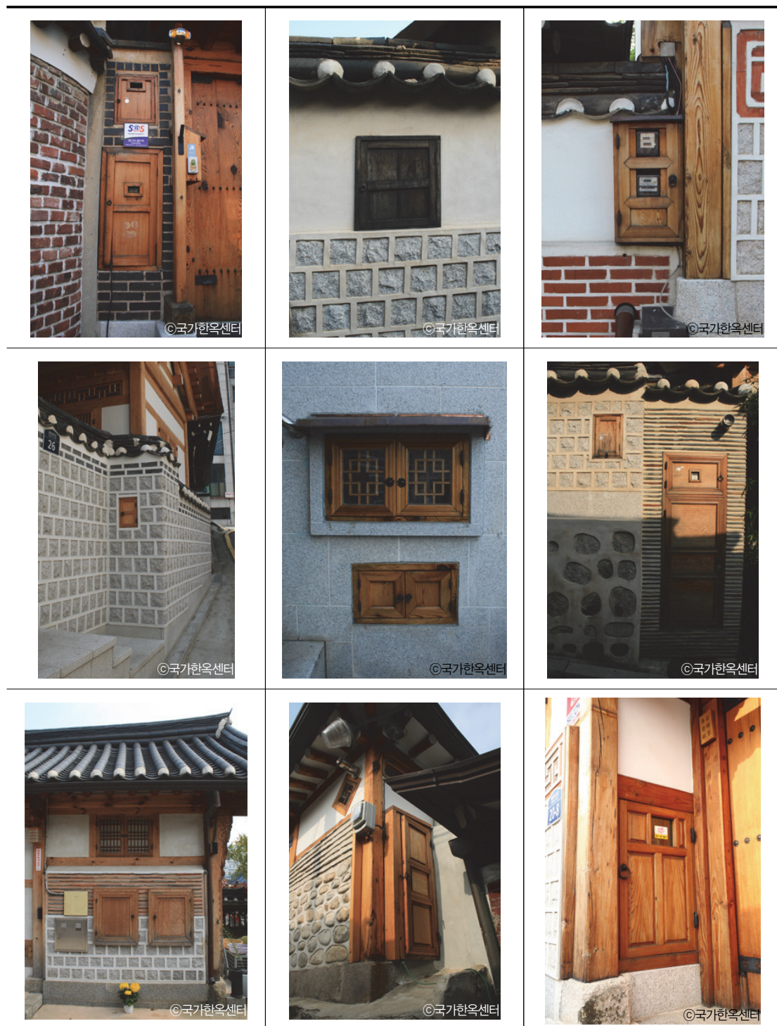
[그림 5-11] 미관을 고려한 전기 및 가스계량기 설치 사례-2
