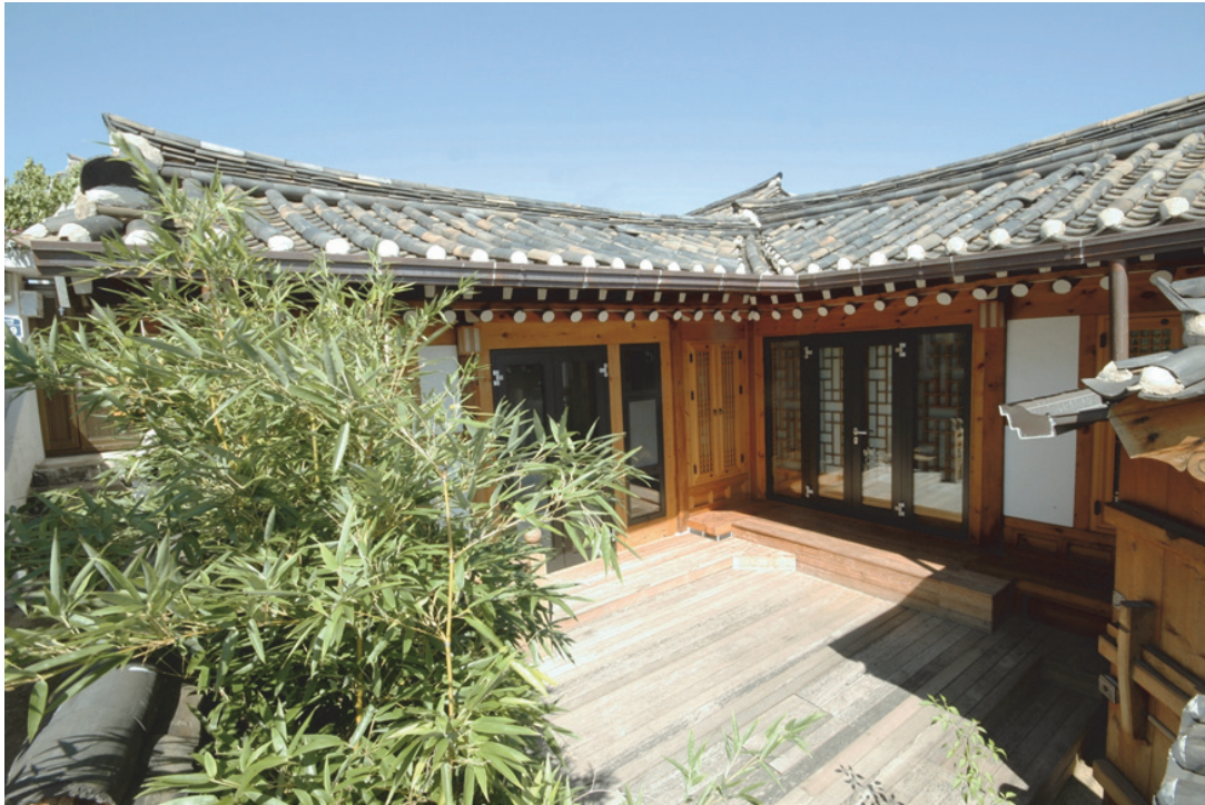
[그림 2-14] 내·외부공간 연결을 위한 기단상부까지 데크로 마감한 사례 (©북촌HRC)
