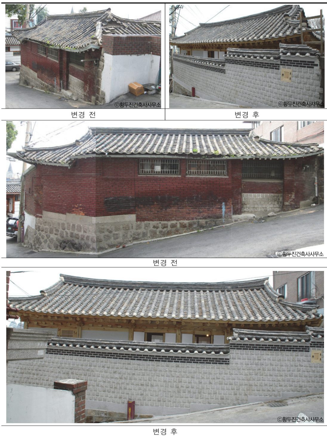
[그림 3-25] 건축물과 담장을 분리하여 설치한 사례-2_변경 전 · 후 사진
