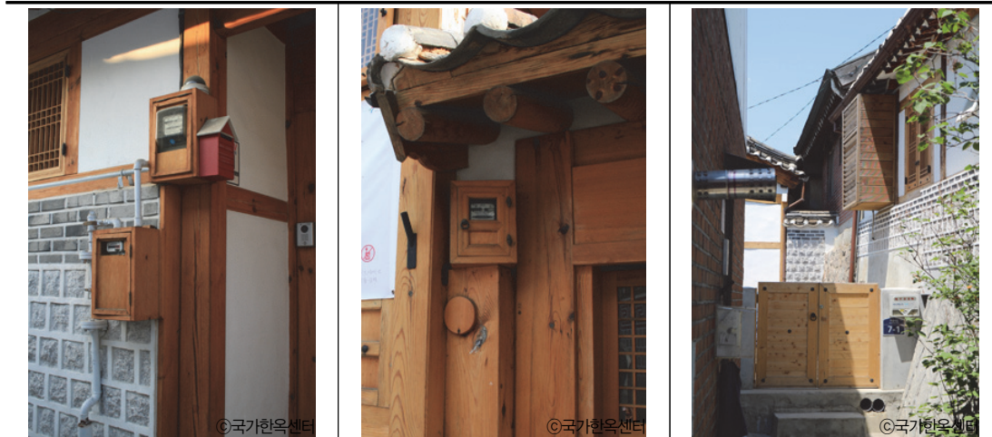
[그림 5-7] 계량기함 설치 사례-1
