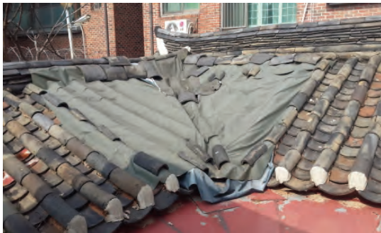
[그림 5-12] 지붕 회첨부위 누수에 의한 처마 손상(자하문로 19_01)
