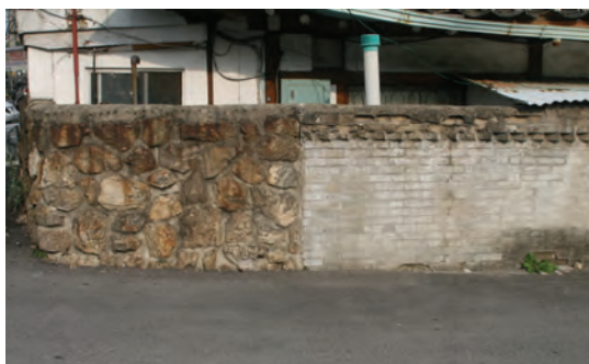
[그림 5-32] 담장의 균열 및 파손(행궁로18_01)
