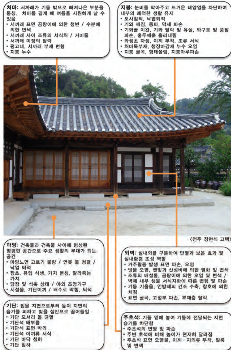
[그림 2-4] 한옥 외관의 주요 결함부위 및 증상 (출처: 국가한옥센터 내부자료(그림), 천득염 외(2013)(글)을 참고하여 재구성)
