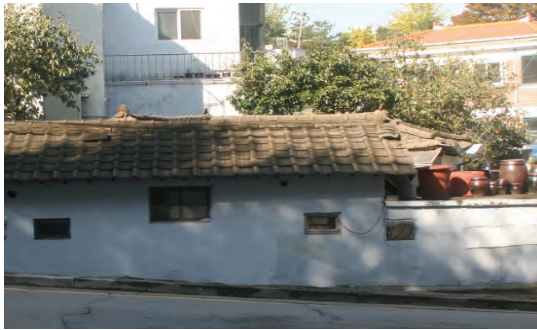
[그림 5-39] 시멘트로 마감한 외벽(화서문로22_01) [그림 5-40] 조적으로 확장한 전면(수원천로316_01)
