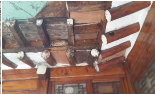
[그림 5-12] 지붕 회첨부위 누수에 의한 처마 손상(자하문로 19_01)
