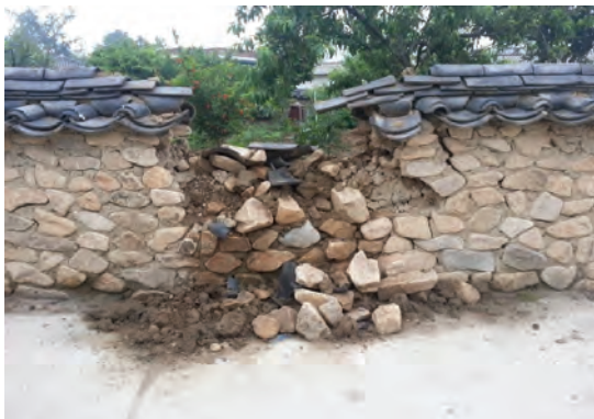
[그림 3-2] 문화재 돌봄사업에 의한 담장 부분보수(담양 창평 삼지천마을 옛 담장) (출처: 문화재청 보도자료('14.2.13))
