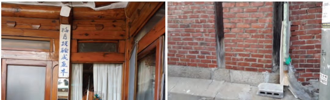
[그림 5-8] 기둥 및 수장재 기울음(자하문로_04)
