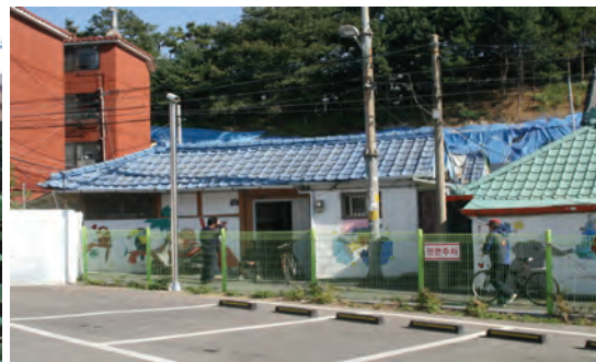
[그림 5-41] 강판으로 덮은 지붕(정조로801_02) [그림 5-42] 천막으로 덮은 지붕(창룡대로30_02)
