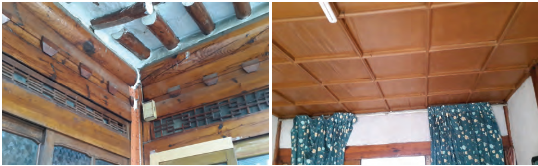
[그림 5-7] 기울어진 기둥을 보강한 모습과 천장 기울음(자하문로19_02)
