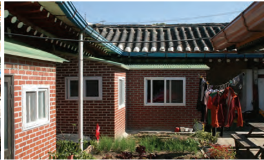
[그림 5-39] 시멘트로 마감한 외벽(화서문로22_01) [그림 5-40] 조적으로 확장한 전면(수원천로316_01)
