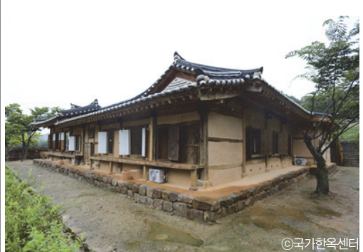
쪽마루 하부공간과 돌출된 반침의 측면을 이용하여 에어컨 실외기 설치
