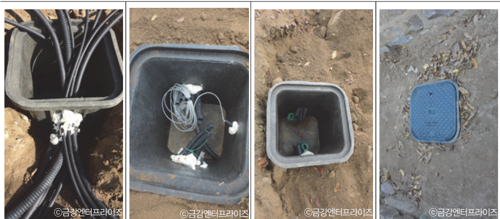
전기 및 통신배선의 점검을 위해 일정간격으로 맨홀 설치
