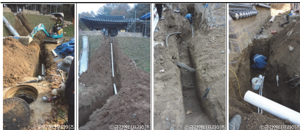
시상하수도 배관으로 연결하기 위한 배관 설치(고택의 급배수를 위한 배관로 설치)
