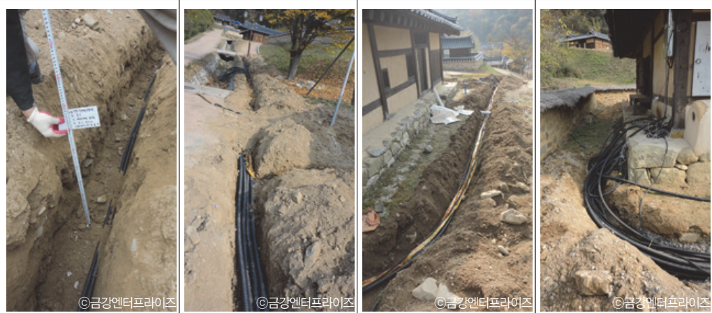
굴착된 위치에 깊이 확인 후 배선 설치
