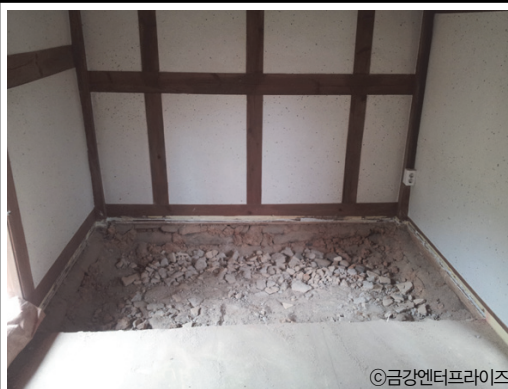
성곡동재사: 화장실 바닥위치 표시 후 바닥철거 후 구들장 제거
