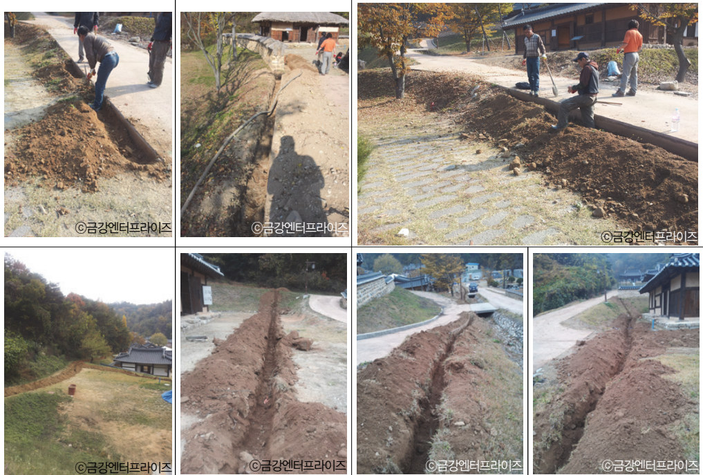
단지 내의 전기 및 통신배선 설치 위치 굴착
