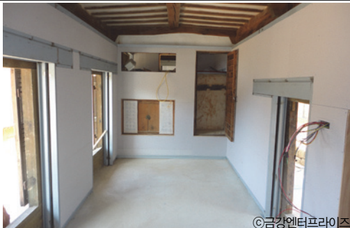
방 내부 금속골조 위 단열재시공 후 석고보드2겹 설치
