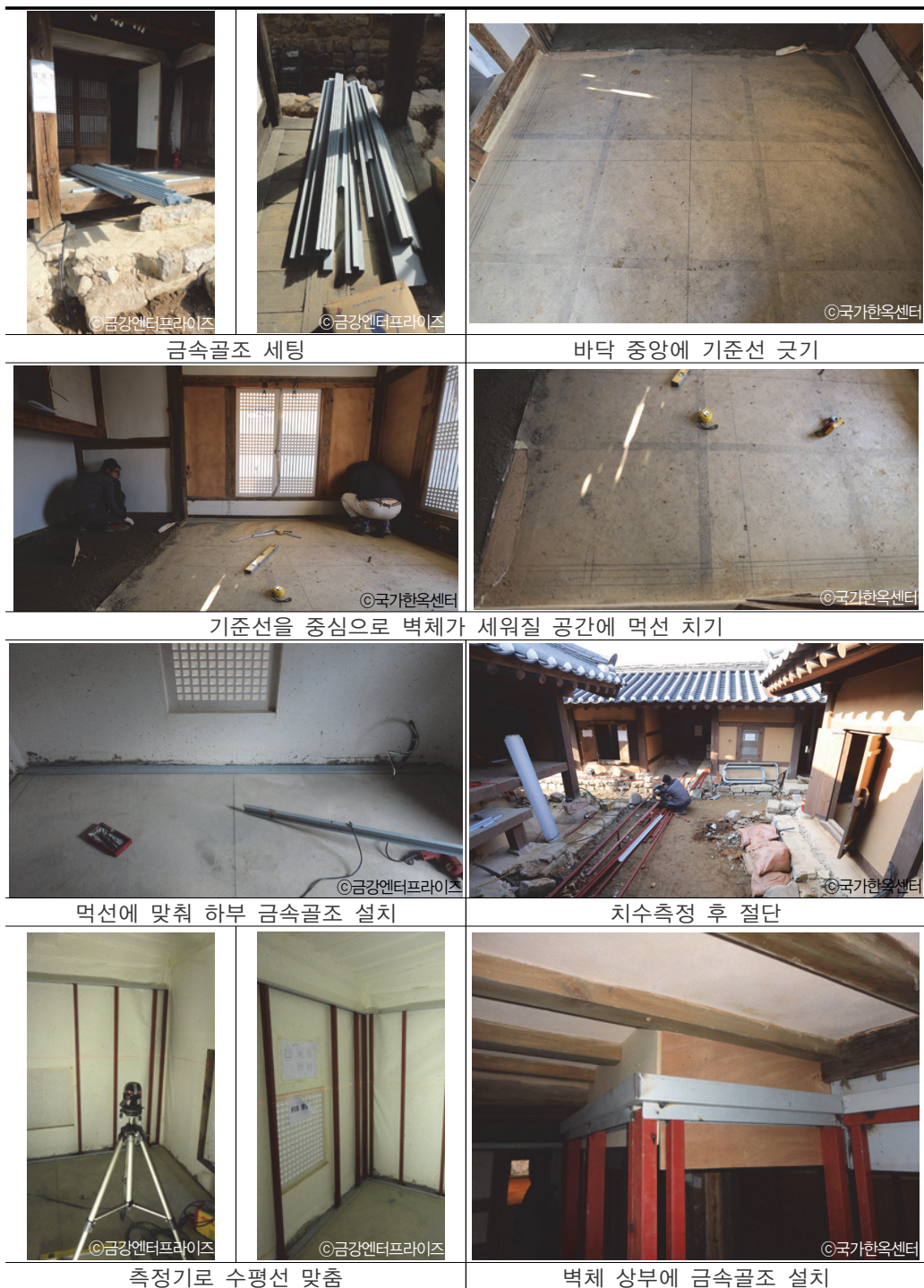
[그림 3-6] 이중벽체 설치 공사-1
