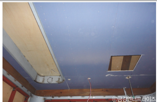
화장실 내부 금속골조 위 단열재시공 후 방수석고보드2겹 설치
