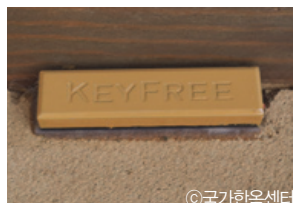
[그림 3-22] 문 상부에 설치된 스마트 시스템과 스마트키
