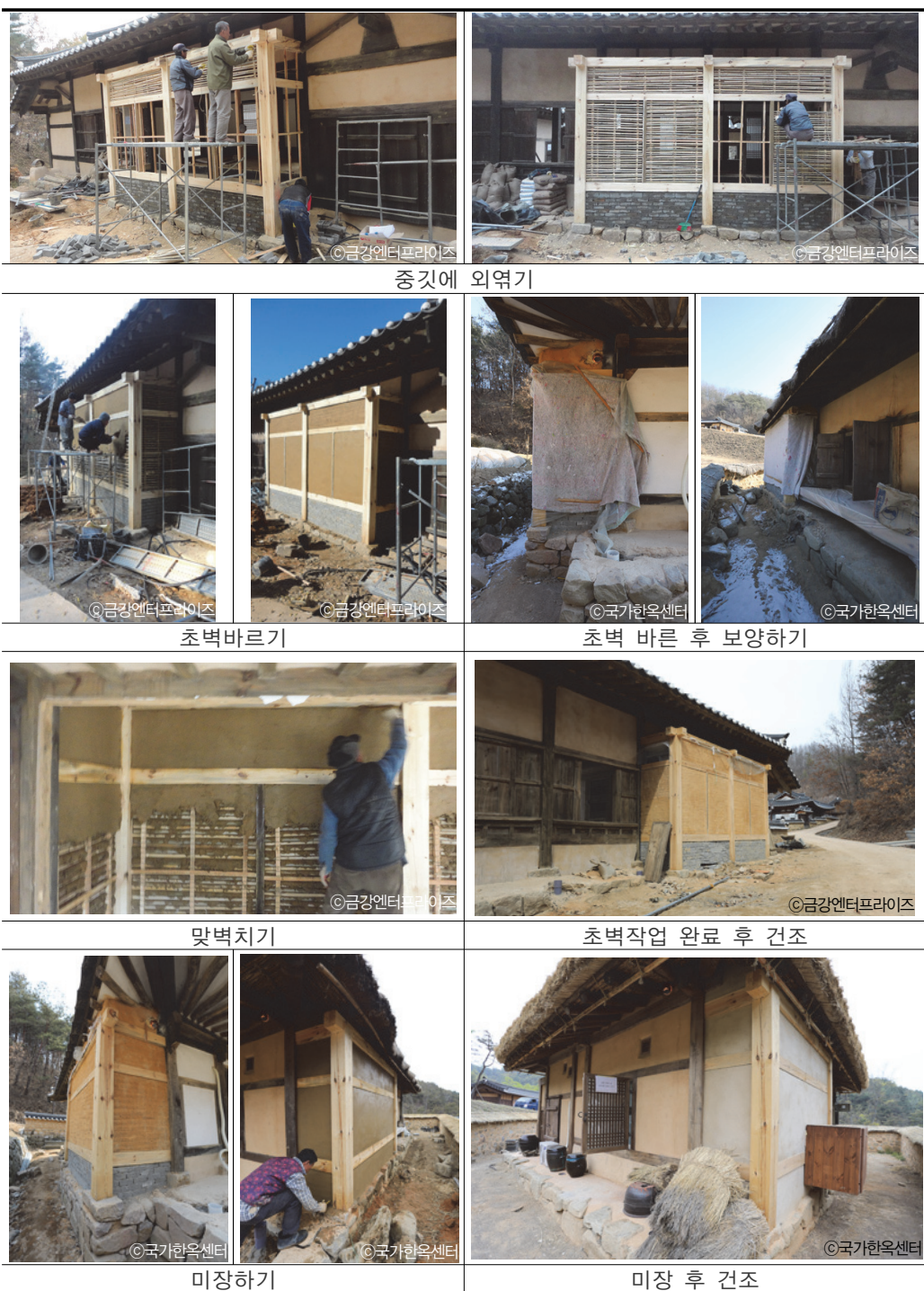
[그림 3-13] 화장실 설치를 위한 증축공사 시공과정-3
