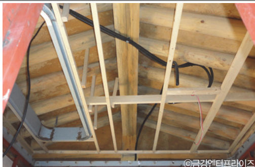
천장마감을 위한 목재천정틀 설치
