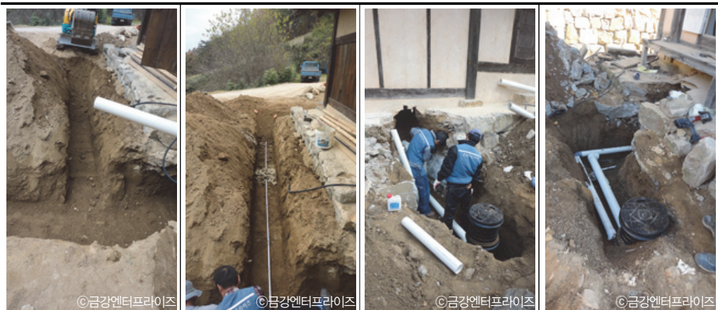
건축물 내 화장실로 들어가는 상하수도 파이프 배관 연결로 설치
