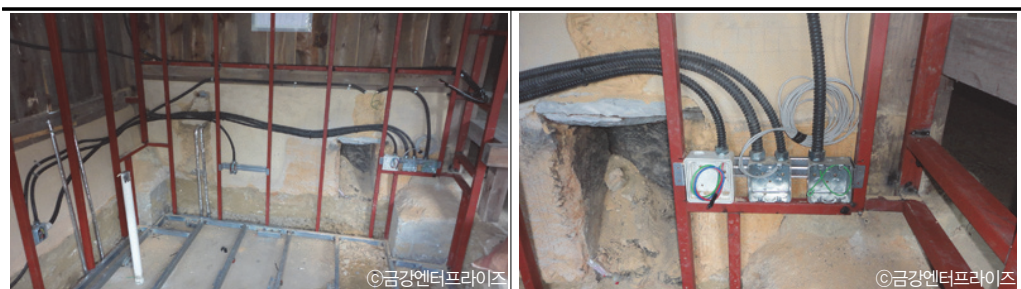
전기 스위치 및 콘센트 위치에 전기 컨트롤박스 설치
