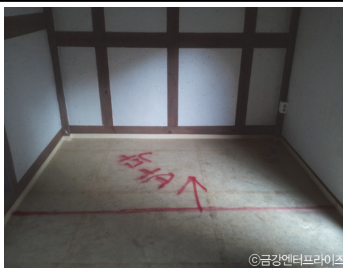
성곡동재사: 화장실 바닥위치 표시 후 바닥철거 후 구들장 제거
