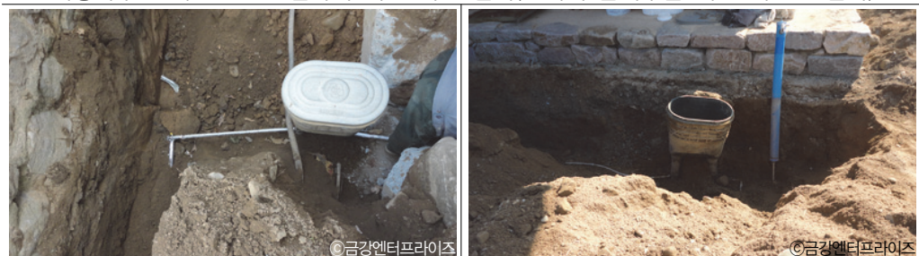
각각의 고택에 수도검침을 위한 계량기 설치
