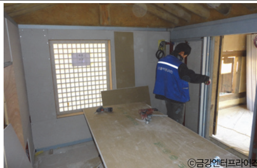
방 내부 금속골조 위 단열재시공 후 석고보드2겹 설치
