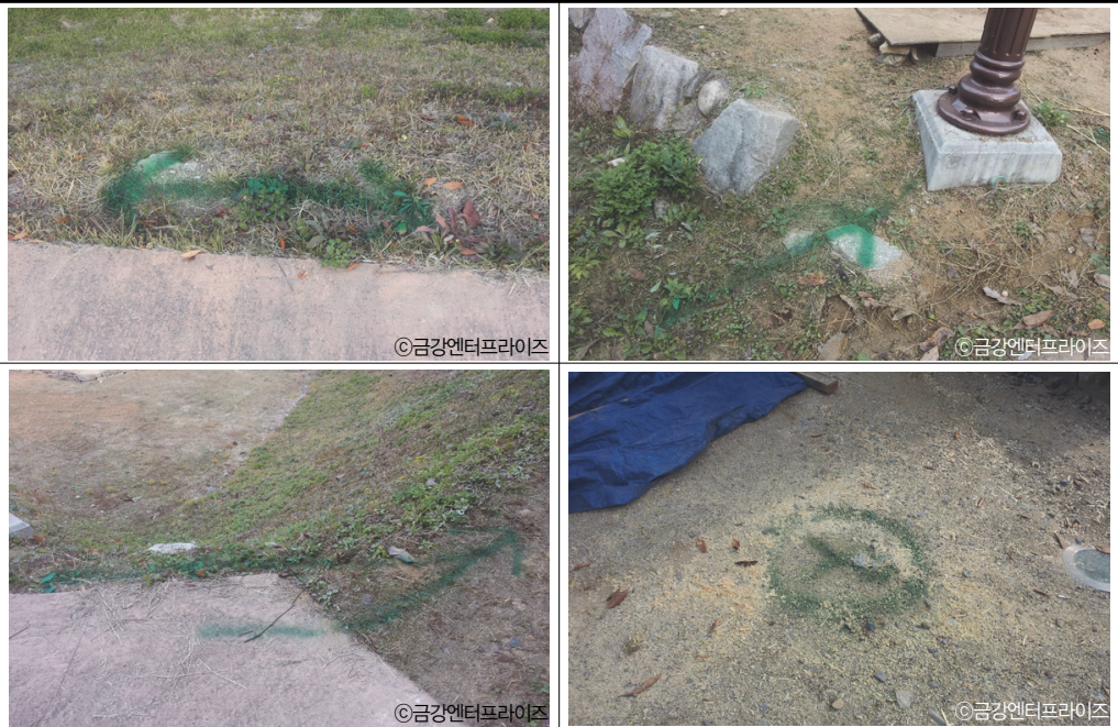
전기 및 통신의 방향과 위치 표시(맨홀 위치 표시)
