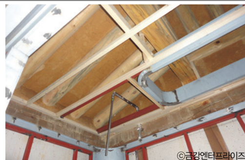
천장마감을 위한 목재천정틀 설치
