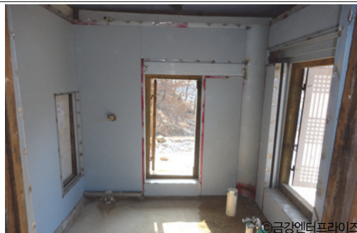
화장실 내부 금속골조 위 단열재시공 후 방수석고보드2겹 설치
