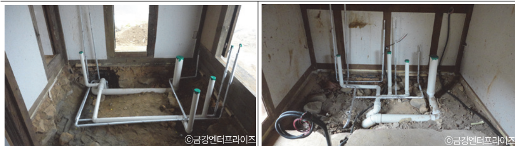
상수도, 오배수관 설치(화장실 세면대, 샤워기, 변기 설치에 맞춰 설치)
