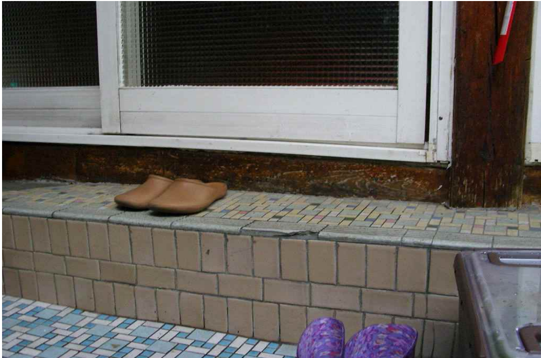
[그림 3-43] 지반 침하로 기단이 내려앉은 모습(2015.11.25 촬영)
