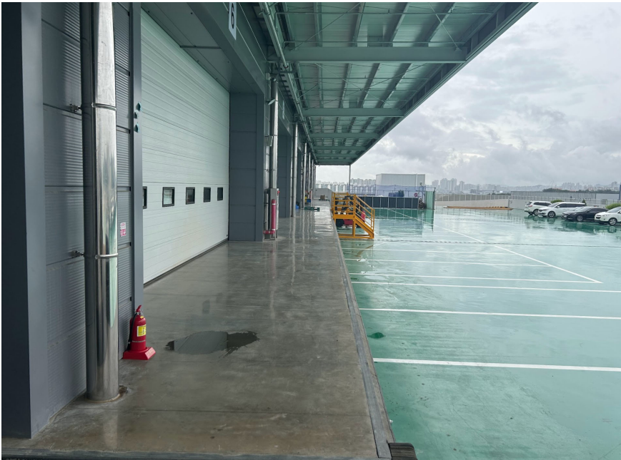
[그림 2-36] A 물류창고 상온창고와 하역장(주차장) 간 방화구획 설치 사례
