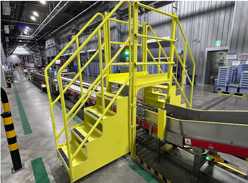
[그림 2-24] D 물류창고 컨베이어 시스템의 브릿지 설치 사례
