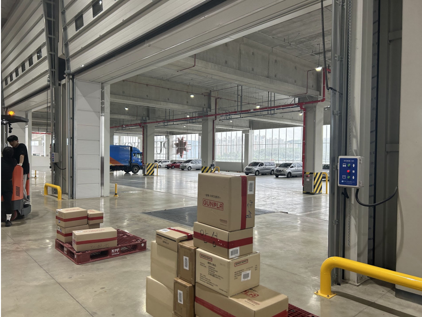
[그림 2-35] A 물류창고 상온창고와 하역장(주차장) 간 방화구획 설치 사례
