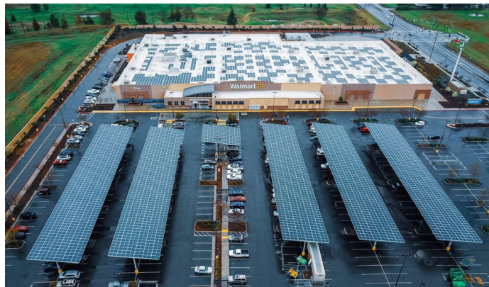
[그림 3-15] 월마트 캘리포니아 매장 옥상에 설치된 태양광 패널
