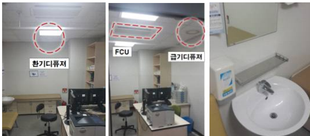
[그림 4-24] 서울 D병원 진료실 급배기구 위치 및 수전설비(직접촬영)
