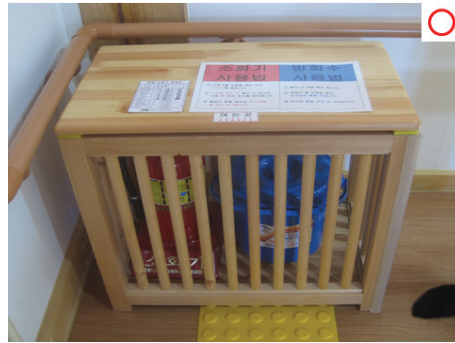
[그림 3-23] 목재건축물 등 방화에 취약한 재료 사용 시 소화기 및 소화수 설치
