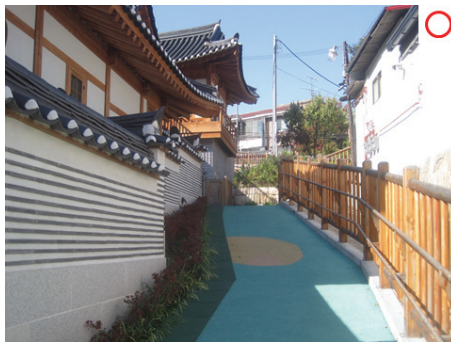
[그림 3-14] 경사로 미끄럼방지 매트 설치
