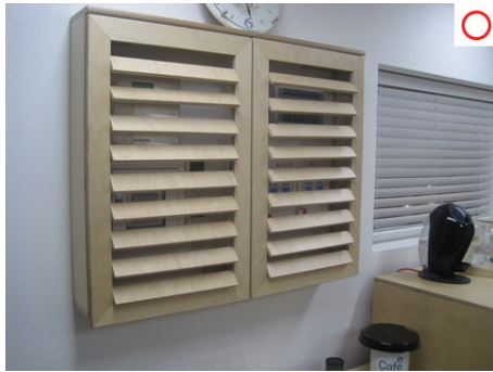
[그림 3-22] 배전반, 전력함 등의 설비 관련 장치 차폐
