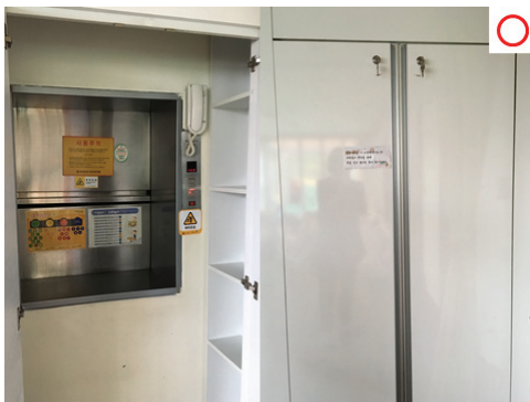
[그림 3-10] 덤웨이트 잠금장치 설치
