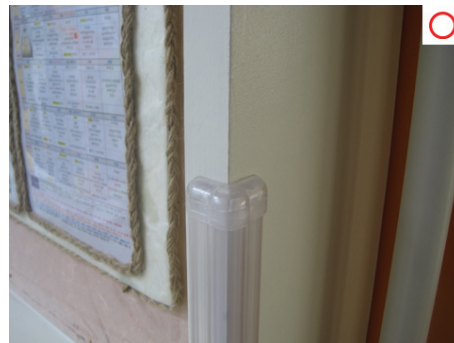
[그림 3-7] 보육공간 내 모서리에 보호대 설치
