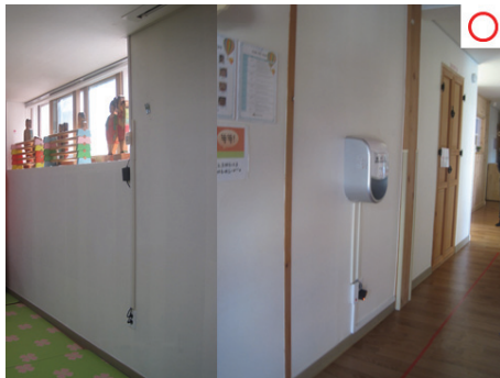
[그림 3-24] 전선이 노출되지 않도록 하고 콘센트에 안전 커버 사용
