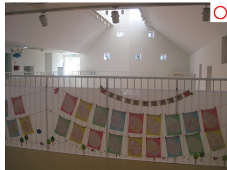
[그림 3-15] 난간에 보호판 설치
