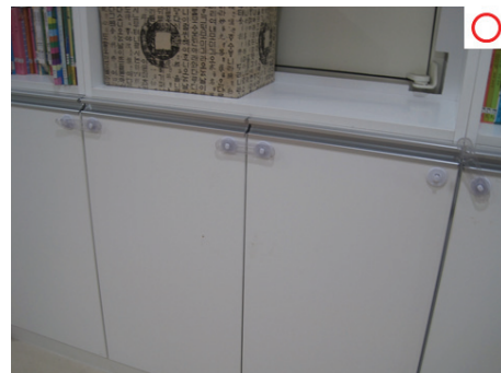
[그림 3-17] 수납장 하부 잠금장치 설치
