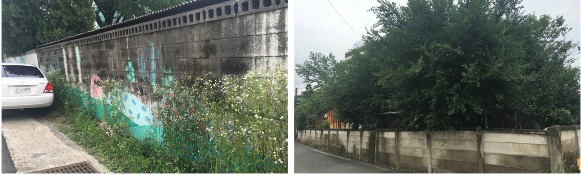
[그림 3-72] 유지보수 및 벽면 도색이 필요한 담장
