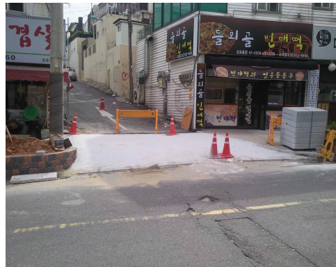
[그림 1-107] 사업 시행 후 모습3(좌:한전지주 차폐, 우:이면도로 진입부분 단차조정) 출처: 정수진
