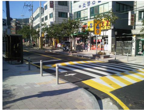
[그림 1-105] 사업 시행 후 모습1(좌:진입로 입구, 우:험프식 횡단보도) 출처: 정수진
