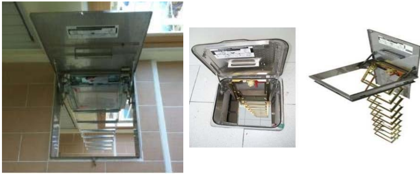
[그림 4-20] 막다른 복도 끝에 하향식 피난구 설치사례 (출처: 한방유비스(주) 내부자료)
