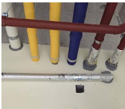
[그림 4-14] 방화구획 관통부 내화실란트 보강사례 (출처: 한방유비스(주) 내부자료)
