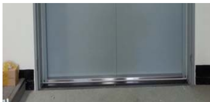
[그림 4-18] 하부 실 미설치로 인한 누설틈새 존재사례(좌) 및 방화문 하부 실 설치 적용사례(우)
