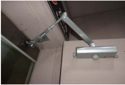
[그림 4-4] 방화형 도어클로저 적용사례 (출처: 한방유비스(주) 내부자료)
