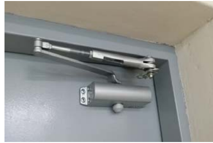
[그림 4-5] 일반 도어클로저 적용사례 (출처: 한방유비스(주) 내부자료)
