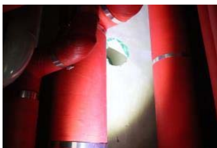
[그림 4-12] 배관 방화구획 관통부 마감 불량사례 (출처: 한방유비스(주) 내부자료)
