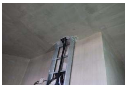
[그림 4-13] 케이블트레이 관통부 마감 불량사례 (출처: 한방유비스(주) 내부자료)
