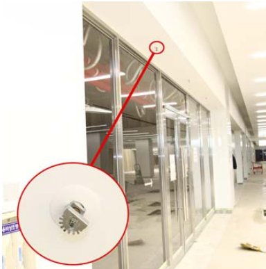
[그림 4-17] 유리벽에 윈도우 스프링클러 설비 적용사례(좌) 및 윈도우 스프링클러 설비 개념도(우) (출처: 한방유비스(주) 내부자료)
