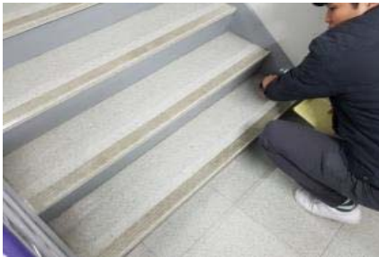
[그림 4-3] 화강석(불연재) 바닥마감재 적용사례 (출처: 한방유비스(주) 내부자료)
