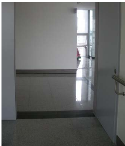
[그림 4-19] 방화문 하부 실 미설치사례(좌) 및 방화문 하부 실 시공사례(우)
