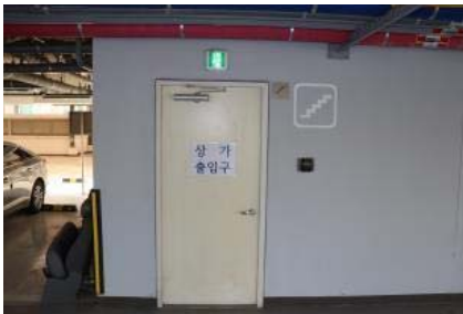
[그림 4-1] 피난계단실 구획 및 방화문 설치사례 (출처 : 한방유비스(주) 내부자료)
