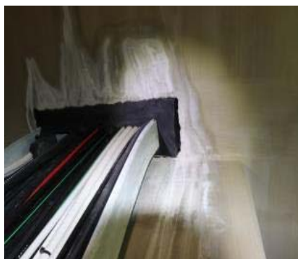
[그림 4-15] 내화충전재를 활용한 케이블트레이 마감사례 (출처: 한방유비스(주) 내부자료)
