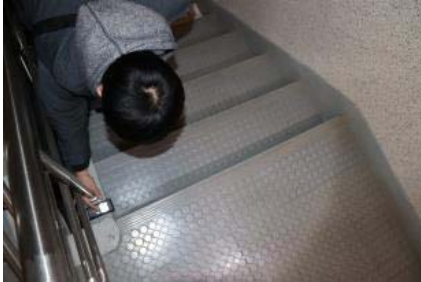
[그림 4-2] 가연성 바닥마감재 적용사례 (출처: 한방유비스(주) 내부자료)
