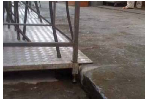
[그림 5-19] 플랫폼은 가능한 한 보도와 동일 높이 출처: New York City Department of Transportation(p2)
