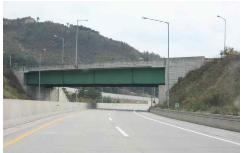
[그림 4-82] 조망권을 저해하는 횡단교량(출처 : '고속도로 경관설계 매뉴얼 2009'_p.81_그림 152)
