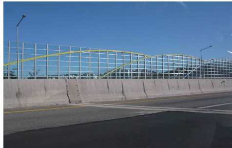
[그림 4-38] 개방감 확보 및 정돈된 디자인 및 색채를 적용한 방음벽_경기도
