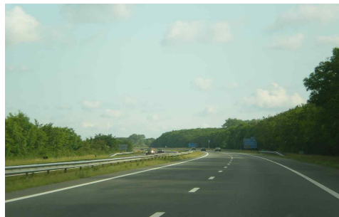
[그림 4-64] 고속도로 노건 쪽 식재를 통한 소음완화 및 대기오염 저감사례(출처 : 동부엔지니어링(2011), 경관도로·도로시설물 출장보고서, p22)
