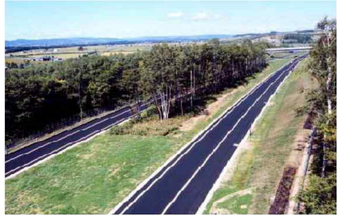
[그림 4-92] 지형과 수목의 파괴를 최소한으로 하는 선형계획_훗카이드 도오지 자동차도로
