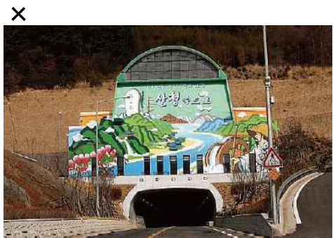
[그림 4-45] 과도한 벽화로 시각적 불쾌감을 초래하는 터널입구(출처 : 서울시)
