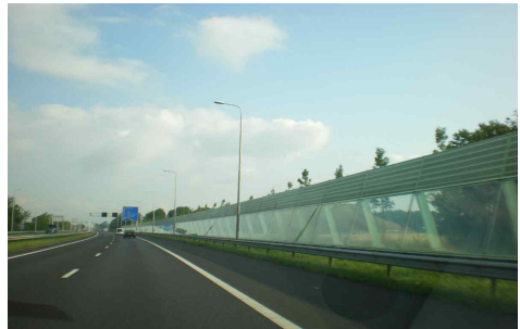
[그림 4-78] 개방형(투명형)방음벽 사례_네덜란드 고속도로 시설물(출처 : 동부엔지니어링(2011), 경관도로·도로시설물 출장보고서, p26.)
