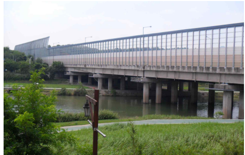
[그림 4-76] 투명방음벽 설치로 인공성 완화 및 주변으로의 조망권 확보
