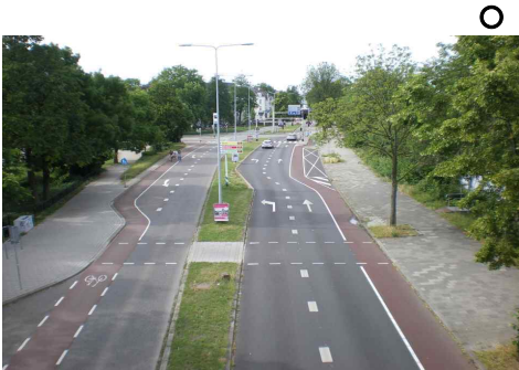
[그림 4-68] 커브 도입 등을 통한 보행자의 안전 확보 및 생활경관 연출(출처 : 동부엔지니어링(2011), 경관도로·도로시설물 출장보고서, p29)
