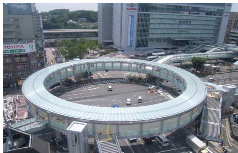
[그림 4-202] 보행데크 설치로 환승동선과 차량을 분리하여 안전과 효율성을 확보한 일본 신요코하마역(출처 : 세계복합환승센터사례집, 한국교통연구원)
