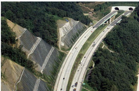
[그림 4-89] 과도한 비탈면 발생으로 인한 지형 및 자연환경 훼손(출처 : '고속도로 경관설계 매뉴얼 2009 p.56, 그림 99)
