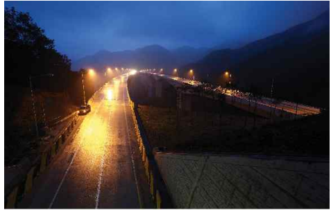
[그림 4-96] 운전자의 안전 및 자연경관을 고려한 야간조명 계획_익산포항선 만덕교(출처 : 고속도로 제77호, 2010, 한국도로공사)
