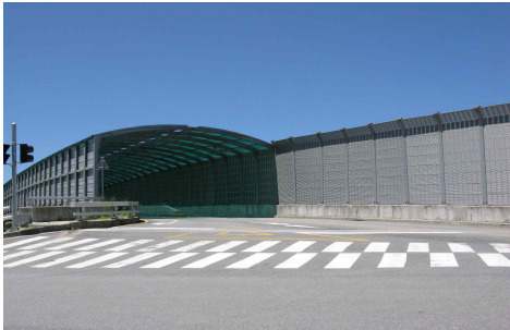
[그림 4-75] 위압감 및 차폐감을 조성하는 불투명 방음터널 및 방음벽_강원도
