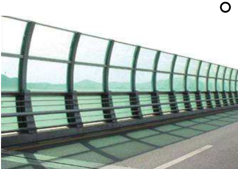
[그림 4-70] 개방성과 조망성이 확보되는 투광형 방음벽(출처 : 고속도로 경관설계 매뉴얼 2009' p.70_그림 135)
