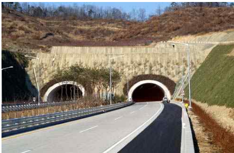
[그림 4-110] 단순한 비탈면 보호공법을 적용한 식재(출처 : 경관도로 정비사업 업무편람)
