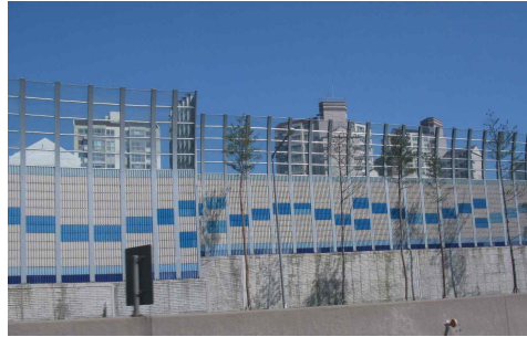
[그림 4-36] 도로경관의 폐쇄성 완화와 주거지역에서의 조망성을 확보한 방음벽_경기도
