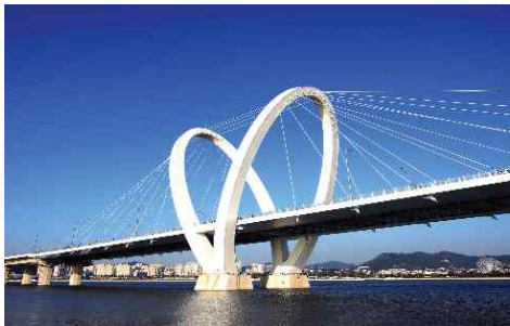
[그림 4-106] 아름다운 외관과 멋진 조망을 제공하는 교량_제2경인선 V형 주탑 강사장교(출처 : 고속도로 제77호, 2010, 한국도로공사)
