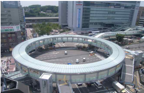
[그림 4-151] 환승편의를 위하여 역사건물로부터 보행데크를 설치한 일본 신요코하마역(출처 : 세계복합환승센터사례집, 한국교통연구원)
