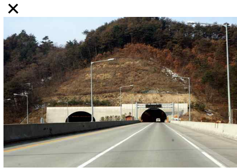
[그림 4-47] 지형훼손이 심한 터널갱구(출처 : 고속도로 경관설계 매뉴얼 2009' p.76_그림 141)
