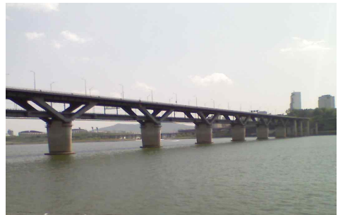
[그림 4-161] 도로와 철도교량을 복층으로 하여 교각의 스케일을 작게 한 청담대교(출처 : ko.wikipedia.org)
