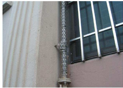
[그림 4-10] 침입방지 설치가 부착된 배관 출처: 이경훈 외(2011, p118)
