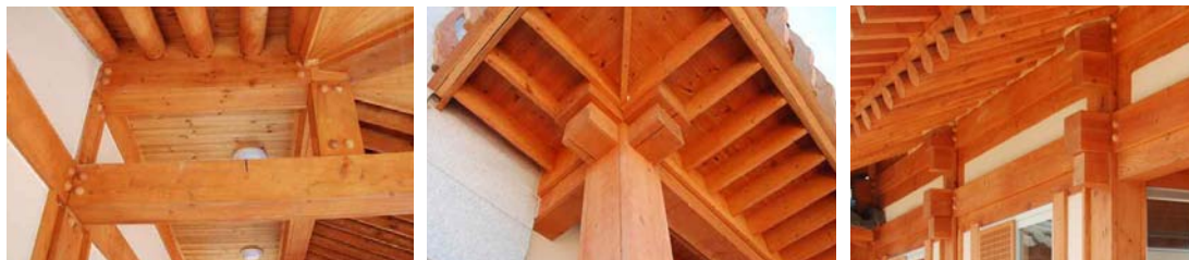
[그림 3-51] 시스템 목재의 결합부 디테일
