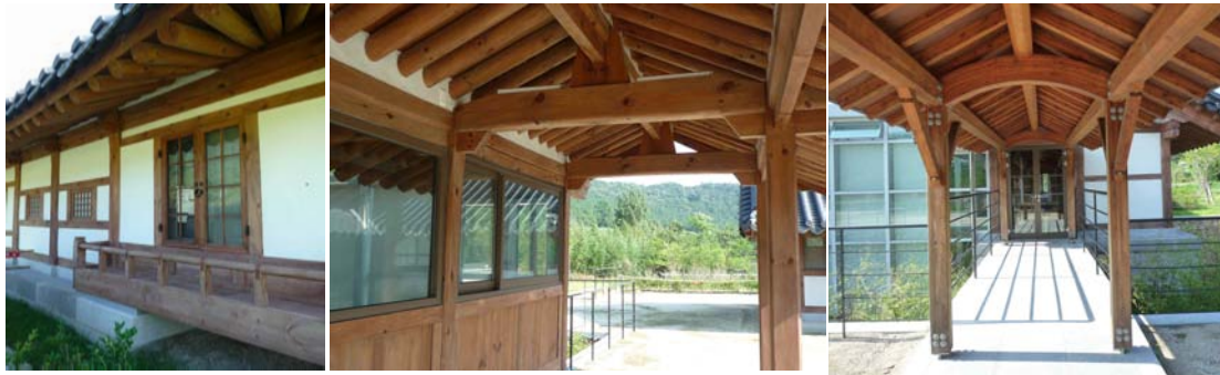
[그림 3-32] 집성목구조 입면 처리 (좌) 북측입면 (중) 남측입면 & 남측 진입부 회랑 (우) 동측 아트리움 회랑
