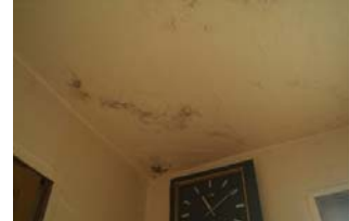
[그림 5.6] 누수로 인한 곰팡이 발생
