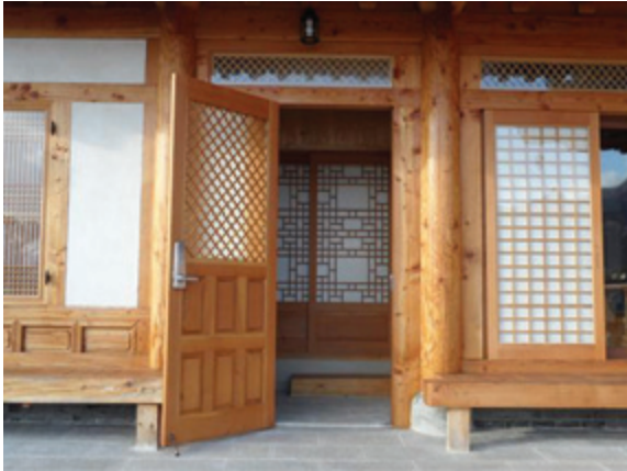
한옥의 단열 성능과 조망·채광을 모두 고려한 현관문 설치 사례
