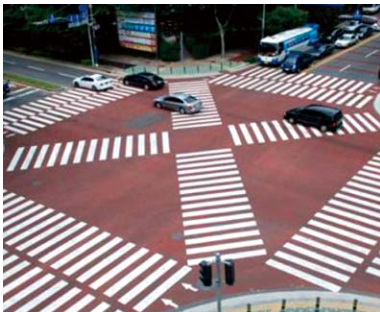
대각선 횡단보도 설치(경기 과천시 우체국사거리 앞) 자료: 경찰청(2015), 횡단보도 설치기준에 관한 연구.
