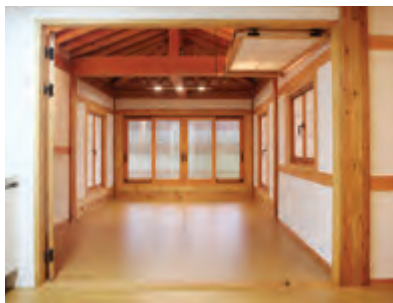
내벽 설치 창호는 전통형·경량형으로, 외벽 설치 창호는 시스템 창호를 설치하여 단열효과를 높인 시범한옥 2층 ©조현정
