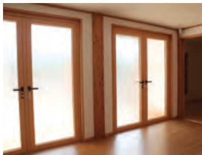
출입문 역할도 하며, 문살을 생략하고 반투명 유리로 마감하여 거주자의 프라이버시 보호가 가능하도록 한 시범한옥 1층 대청 창호 ©조현정
