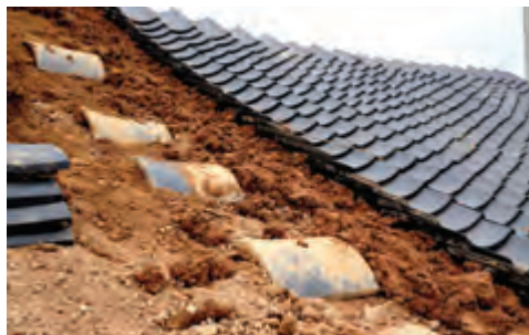
전통한옥의 지붕공사 (암키와 설치) ©조현정
