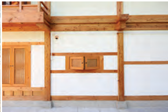
쪽인방을 설치한 시범한옥 벽체 모습 ©조현정
