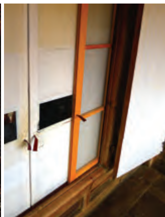
전통창호에 일부 유리와 모기장을 설치하여 거주자의 편리함을 더한 사례(서산 김기현 가옥) ©조현정
