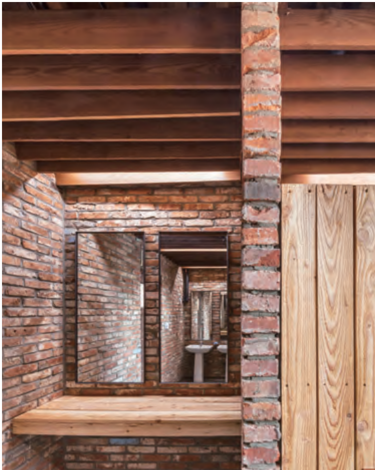
경농관 화장실 ©신경섭
