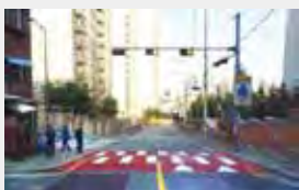
고원식 횡단보도(강남 개원초)
